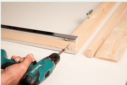
4. Anschrauben der unteren Türschwelle
