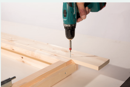
7. Anschrauben der Blende oben
