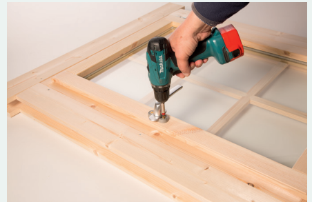
6. Anschrauben / Montage Fenstergriff
