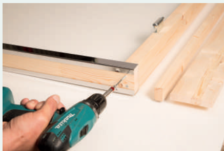
4. Anschrauben der unteren Türschwelle
