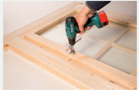
6. Anschrauben / Montage Fenstergriff
