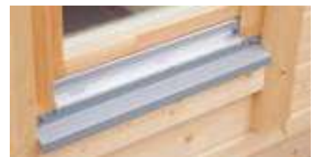
Fenster mit Metall-Fensterbank
