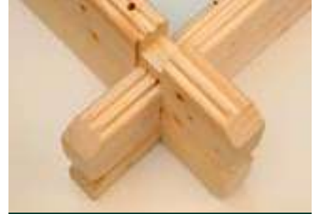
Winddichter Eckversatz
