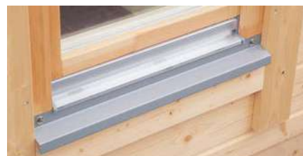
Fenster mit Metall-Fensterbank
