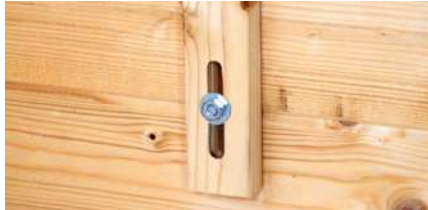
Sturmleiste bei Wandstärken 28 und 40 mm
