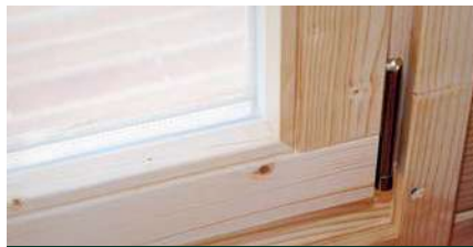
Isolierverglasung ab 34 mm Wandstärke
