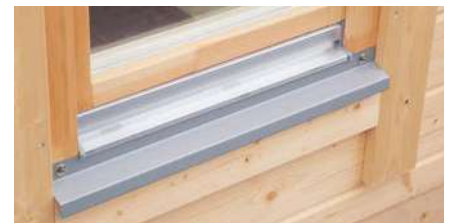
Fenster mit Metall-Fensterbank
