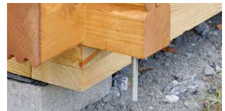
Gewindestangen ab Wandstärke 44 mm
