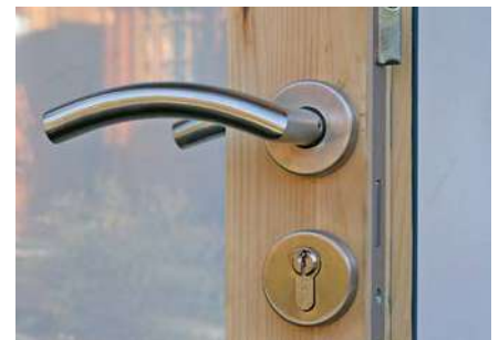
Edelstahl-Türbeschlag und Zylinderschloss
