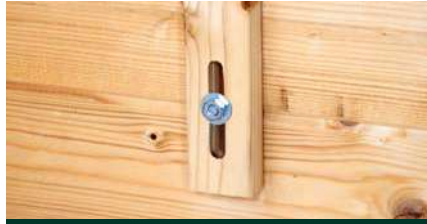
Sturmleiste bei Wandstärken 28, 40 und 44 mm
