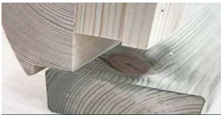
Wandelement auf imprägnierten Rahmen
